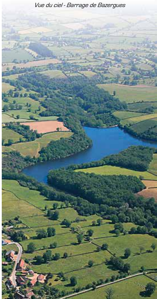
Vue du ciel - Barrage de Bazergues
